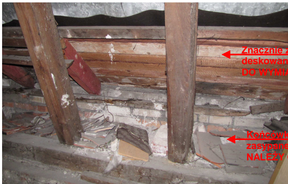
Fot. 4 Mocowanie krokwi na murłacie
